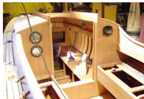
SK 40-es építés közben
