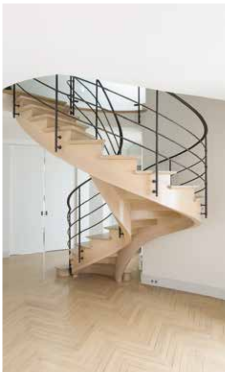
Ez az íves falépcső egyben önhordó szerkezet is
