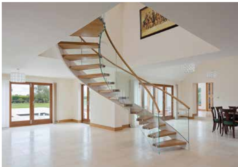
Üvegkorláttal kombinált falépcső acélszalag-gyámolítással
