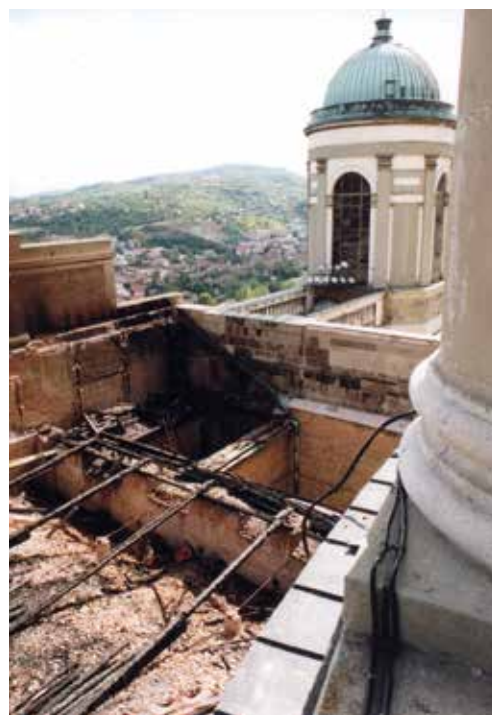
Az eldeformálódott rézlemezfedés maradványai utalnak a tűz hevére, Esztergom, 1993. (Schlosser Attila építész felvétele)
