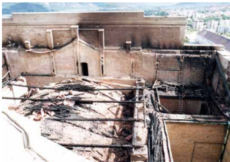
A XIX. században épült teljesen eredeti tetőszerkezet semmisült meg az 1993-as esztergomi tűzeset során (Schlosser Attila építész felvétele)
