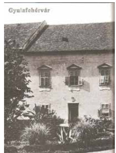
7. kép: Zsaluk. A földszinten már, két üvegrétegű ablakok vannak
