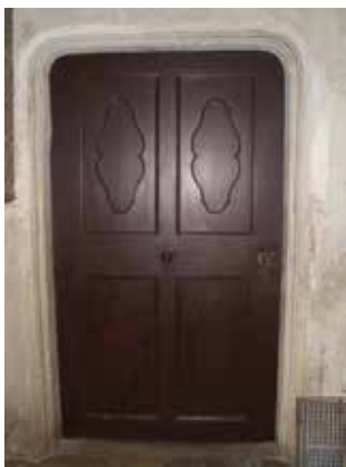
3.a kép: Keretbetétes ajtó kívül kilinccsel és behúzó gombbal
