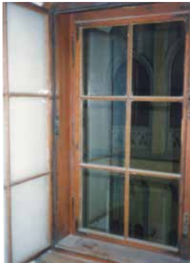
10. kép: Béléssel kötött, gerébtokos, be-be nyíló ablak (1860)
