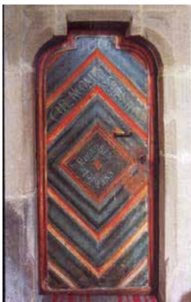
2. kép: Kétrétegű deszkaajtó
