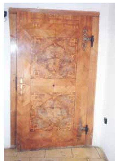
13. kép: Rakottas keresztajtó kereszt-pánttal, közepén a húzógomb nyomával és utólag bevéssett zárral
