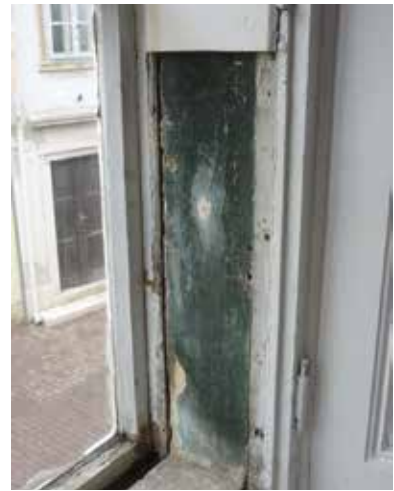
9. b kép: Kapcsolt gerébtokos, ki-be nyíló ablak bontásakor látszik a korábbi festett „falbélés” és rajta a későbbi deszkabélés
