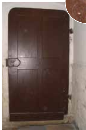
3. b kép: Keretbetétes ajtó belül díszes keresztpántokkal és borított zárral
