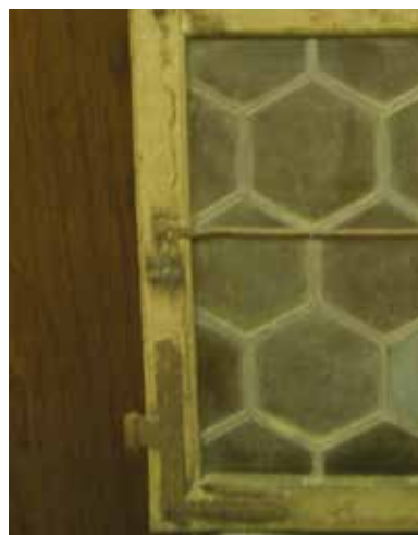
6. kép: Ólomüveges ablakszárny, az üveget tartó vaspálcákkal
