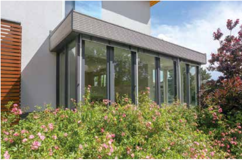
Lakóházhoz kapcsolt télikert háromrétegű hőszigetelő üvegezéssel
