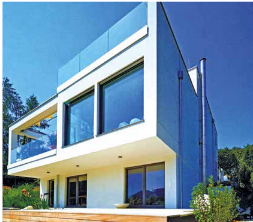
Többszintes passzív ház, emeletén fix üvegezésű ablakozással, míg az alsó nappali funkció miatt az erkélyajtók toló-nyíló működtetéssel biztosítják a lakás-kert kapcsolatot
