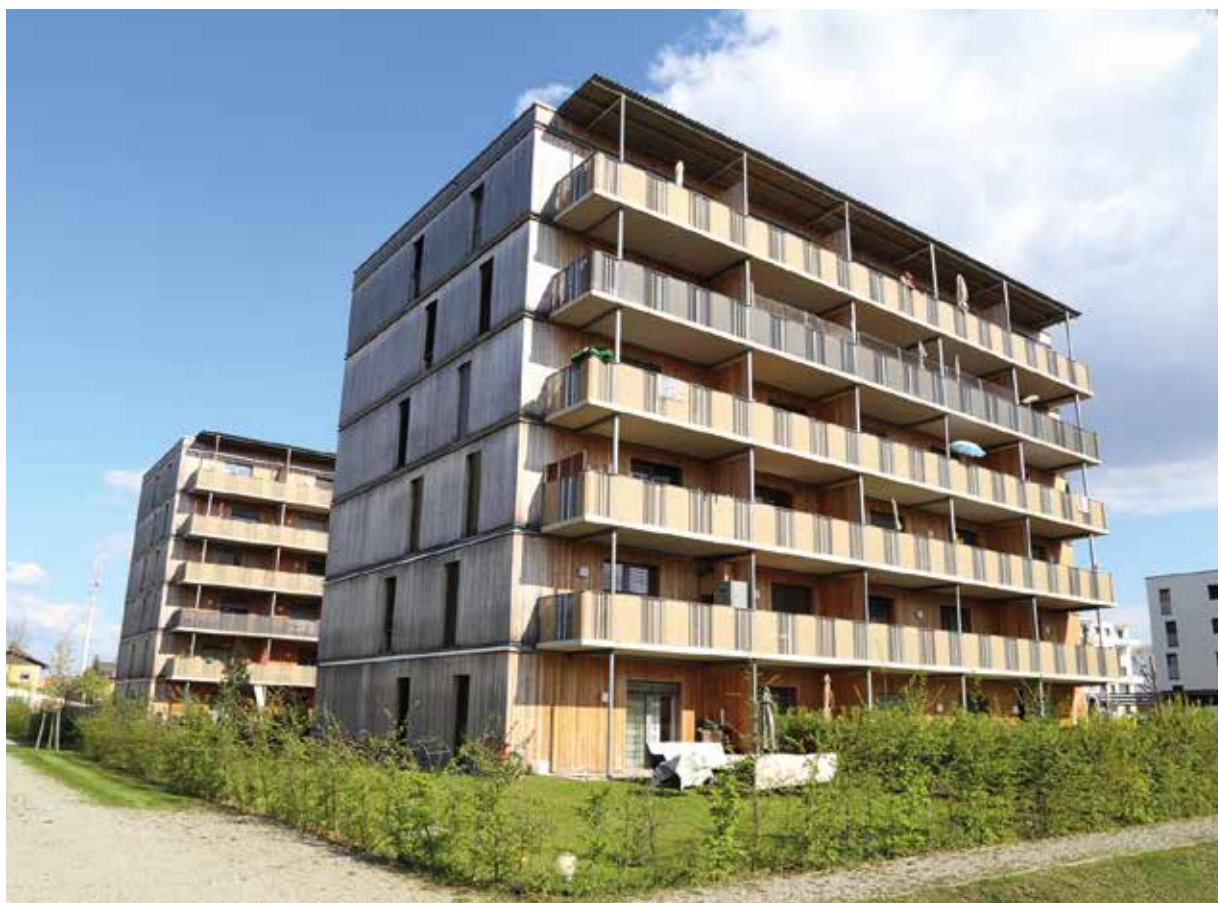
Az elsőként épült hatszintes fa társasház Grazban
