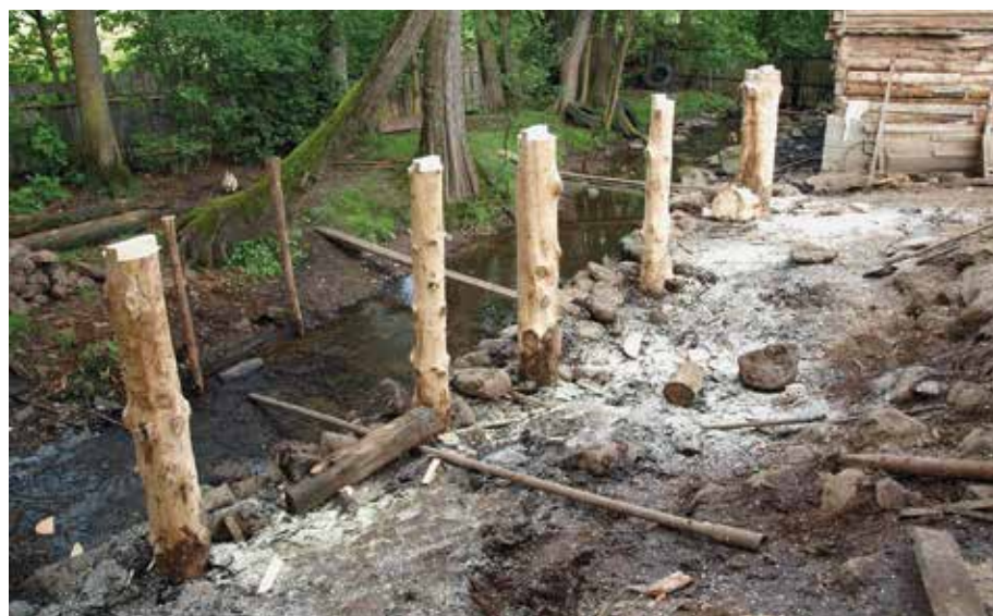
A patakparti új cölöpsor
