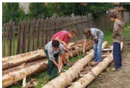
A beépítésre váró rönkök kérgelése
