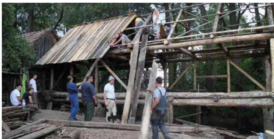
Elkezdődött a tető héjalása
