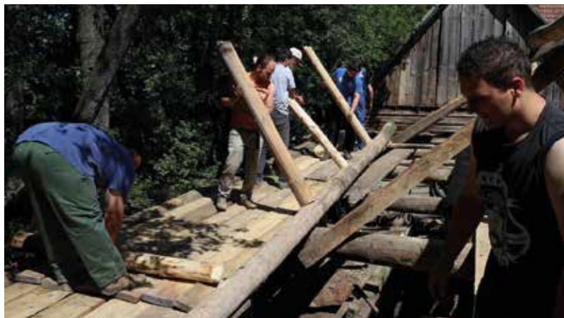
Az összeállított falelem felállítás előtt
