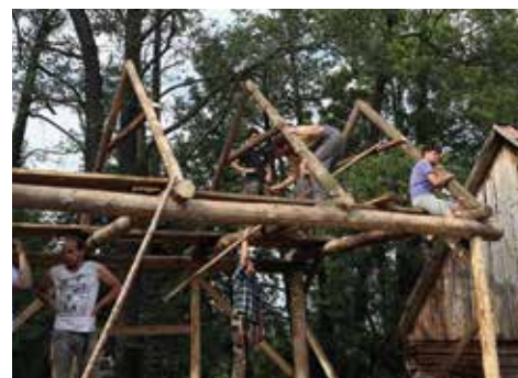
A szaruállások határozzák meg a tető formáját
