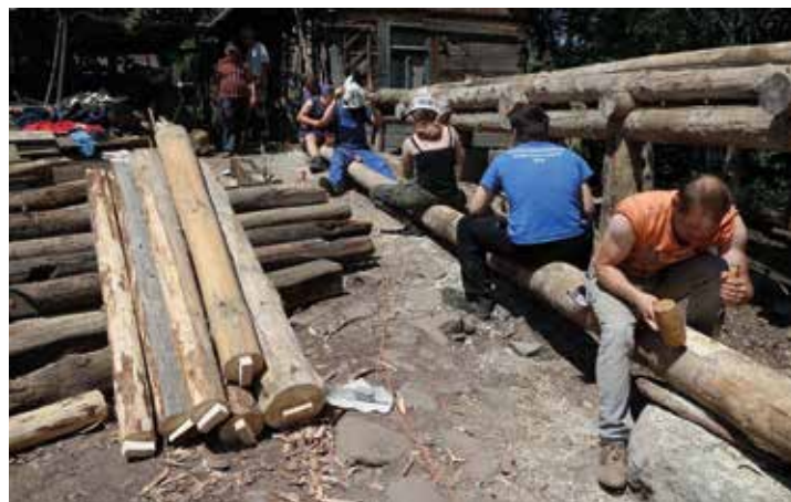
A tartóoszlopok és a szelemen csapozása összeépítéshez
