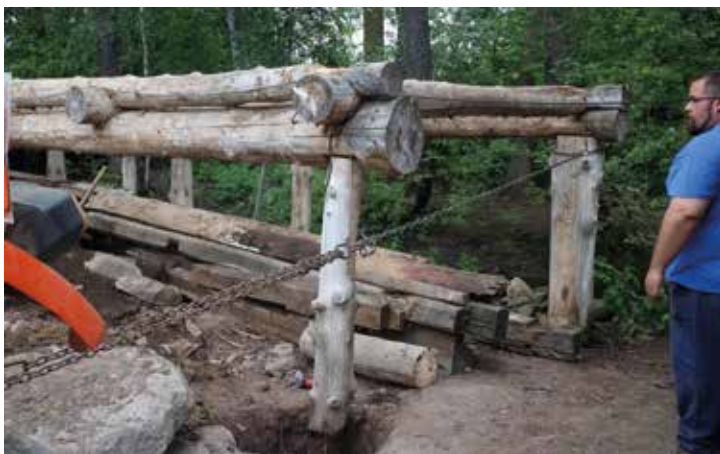
2018 – A beszűrűlt, elcsúszott gerendák visszahúzatása
