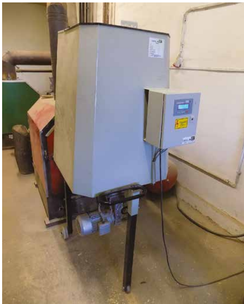
30 kW-os, magyar gyártmányú, Halex 3 típusú apríték-tüzelő berendezés.
