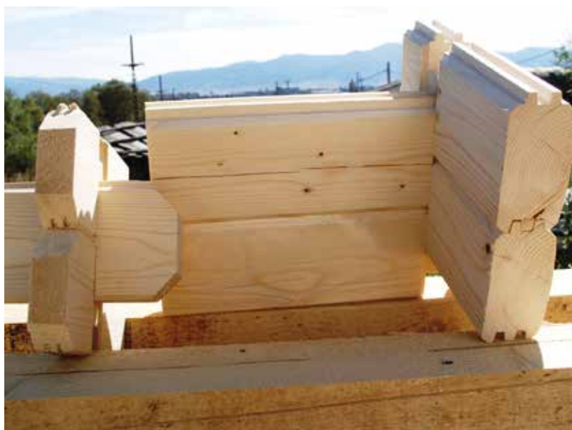
Dupla nűtféder illesztésű gerendaházak építési rendszer
