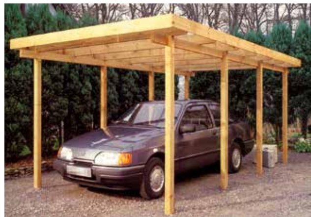
Favázrendszerű autóbeálló legegyszerűbb megoldása. Figyelem, ehhez hasonlókat semmiképpen nem ajánlunk a megkérdőjelezhető stabilitás miatt!
