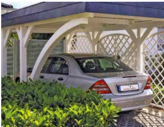
Igényes kivitelű favázás autóbeálló kétirányú rácselemmel, amely egyben a szélrács szerepét is képes betölteni
