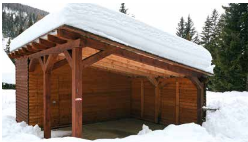
Tűzifatárolóval együtt készült, két jármű fogadására alkalmas, favázrendszerű autóbeálló
