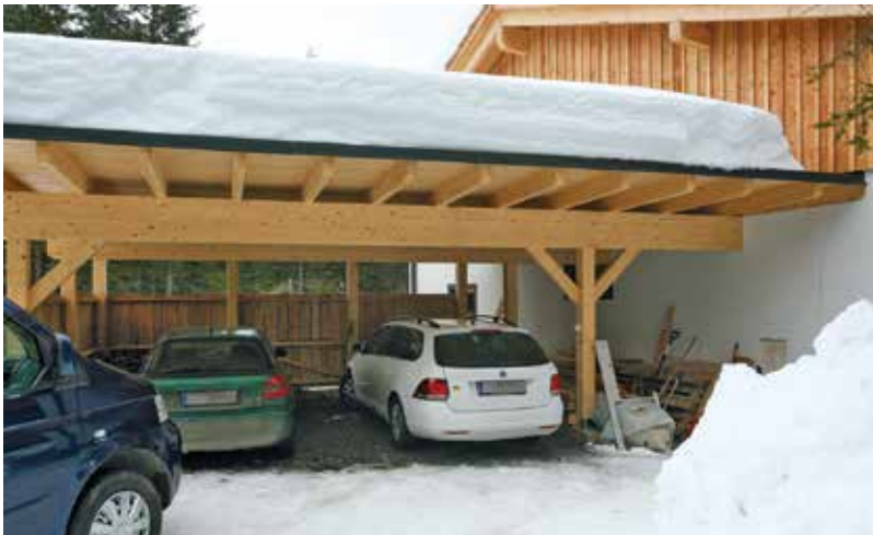
Hagyományos építésű házhoz kapcsolt, két jármű fogadására alkalmas, favázrendszerű autóbeálló
