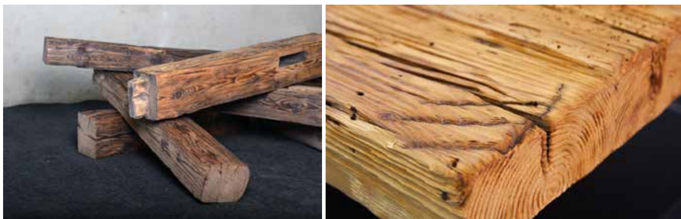
Rusztikus kandallópárkány, akár bontott faanyagból is készíthető, ez esetben gondoskodni kell a favédelemről. (Fotó: Szemesváry Petra)
