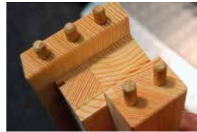
2. kép: illesztett kontraprofil köldökcsappal
