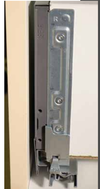
A hátlap csatlakozásán a mélyhúzás nagyobb merevséget biztosít a fióknak.
