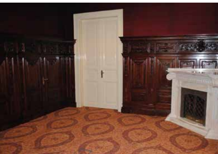
Egy átköltöztetett, restaurált falburkolat.
