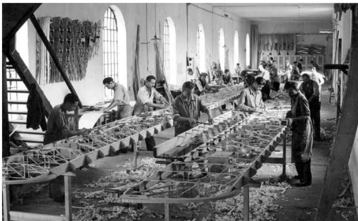
Id. Rubik Ernő repülőgépei készülnek az esztergomi repülőgyárban, a '30-as években. Ismerte és kihasználta a rétegtlemez mechanikai tulajdonságait! (Kép a szerző gyűjteményéből.)
