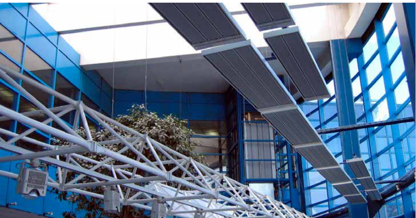
Függesztett infrapanel/feketesugárgó, magas légtérben is elérhető a munkakörnyezetbe bejuttatott ideális hőmennyiség.
