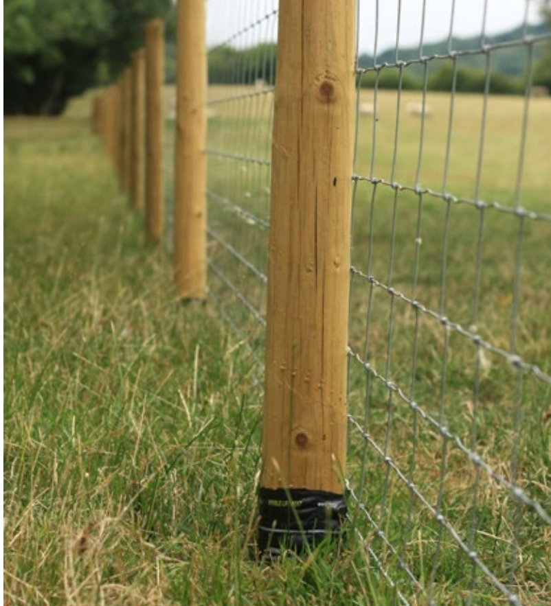
Postsaver fóliával védett oszlopok sora. (houtkoning.nl)
