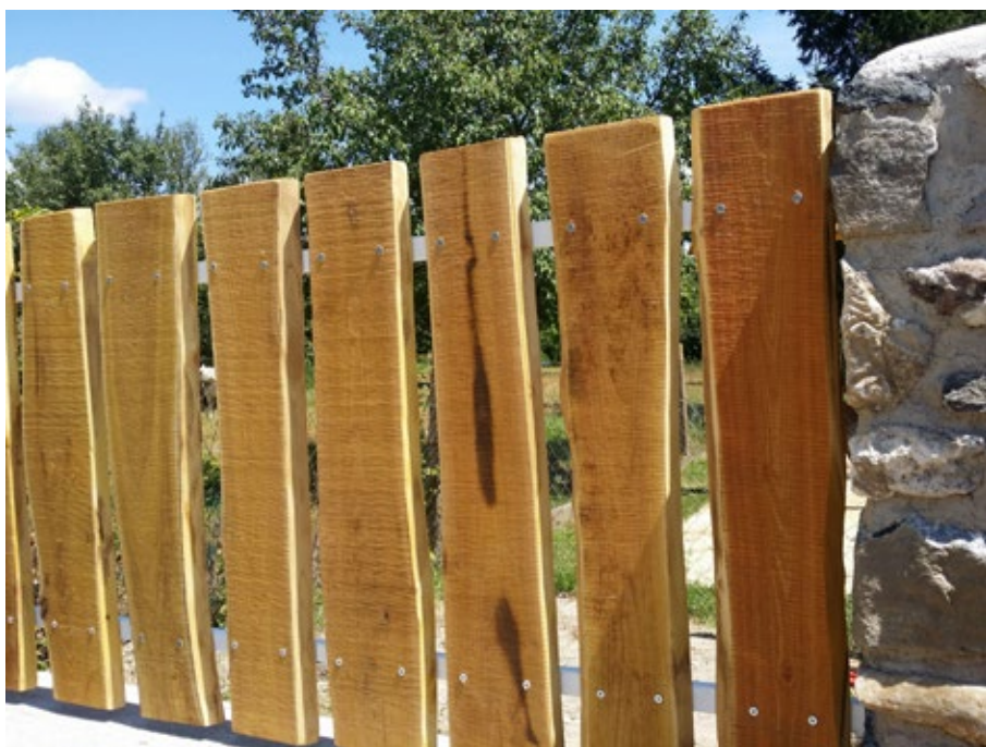
Szélezzel deszkakerítés építésénél gondolni kell a szíjács gyenge tartósságára, tölgy alapanyag esetén pedig a csersav okozhat nem kívánt elszíneződést a fémfelületekkel érintkezve. (ildare.unas.hu)
