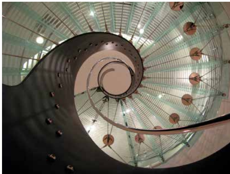
A '80-as években Eva Jiricna cseh származású építész és tervező üvegből és rozsdamentes acélból készült lépcsőket kezdett tervezni, ezek elegáns és futurisztikus megjelenése ma is kedvelt, sőt meghatározó korunk építészei számára. (archdaily.com)
