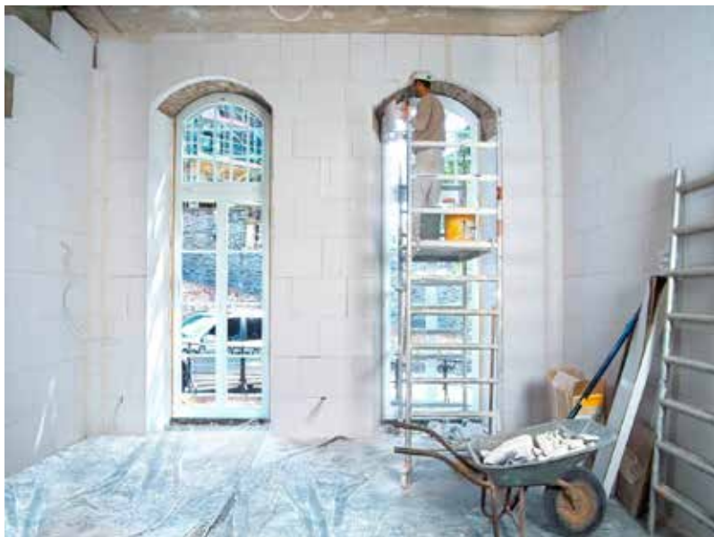
A Multipor ásványi hőszigetelő rendszerrel párazáró réteg beépítése nélkül is könnyen kialakítható belső oldali hőszigetelés. Emellett a Multipor nem csak belső oldalon használható, az épület külső homlokzati hőszigetelésére is alkalmas. (static.region.hu)
