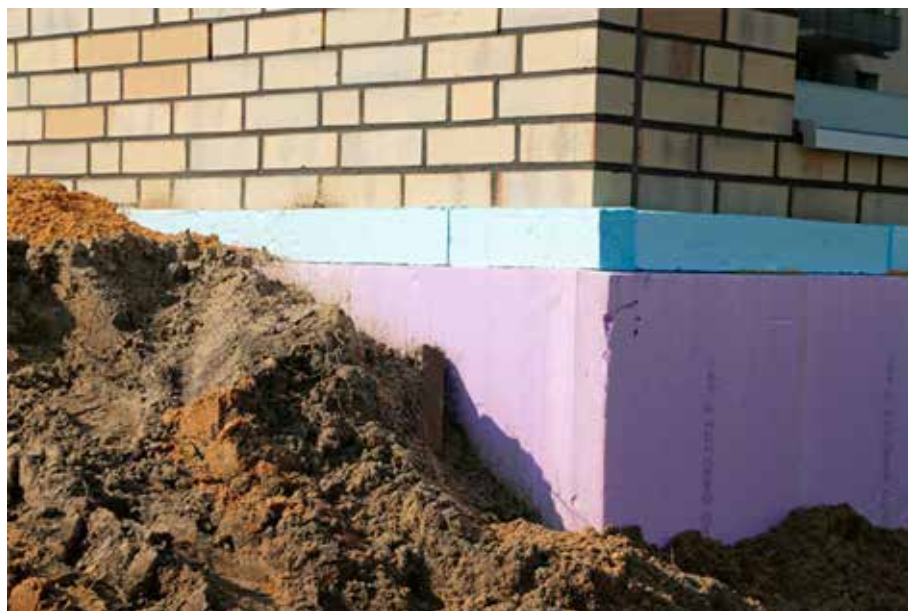
A lábazati szigetelés is nagy szerepet játszik a fűtési költségek csökkentésében, erre a zárt cellás XPS lapok – melyek vízfelvétele minimális – kiváló választást jelentenek. (gsv.hu)
