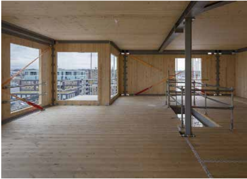
Acélszerkezetek a 10 emeletes Bayan Wharf-i irodaépületben (tervező – Hawkins & Brown)
