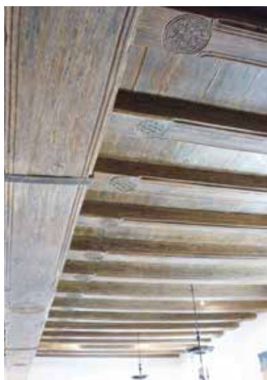
A kolostor fafödéme, a helyreállítás után (a szerző felvétele)
