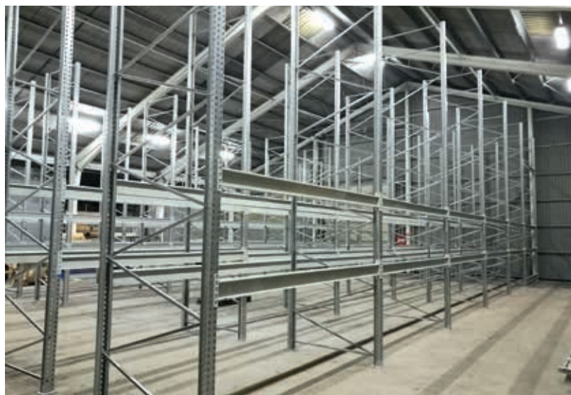
Speciális, nagy teherbírású raklapos állvány építése a Gamper Üzletháznál
