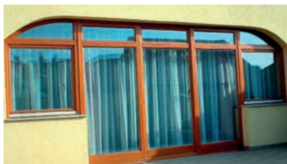
5. sz. kép: alkatrészben felületkezelt és a helyszínrre szállított portál
