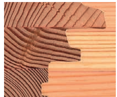
7. sz. kép: ablaktok csapos és kontraprofilos kötése
