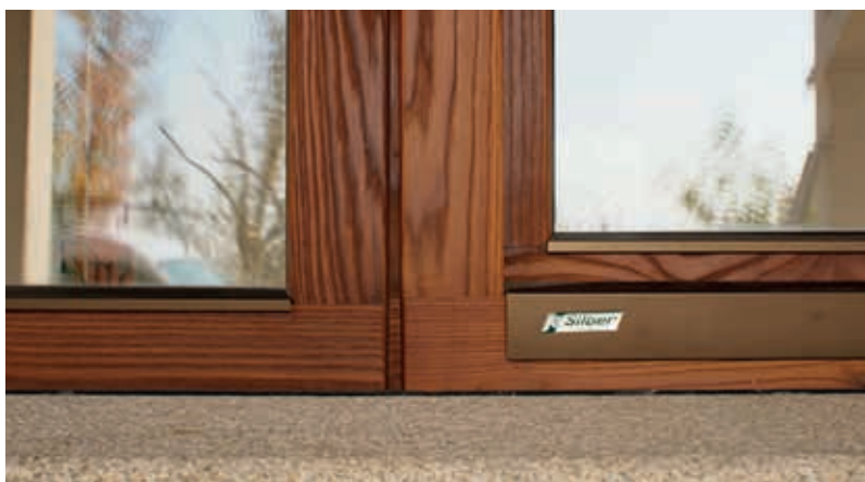
Olajozott, műgyantával impregnált faablak (forrás: Natwood)
