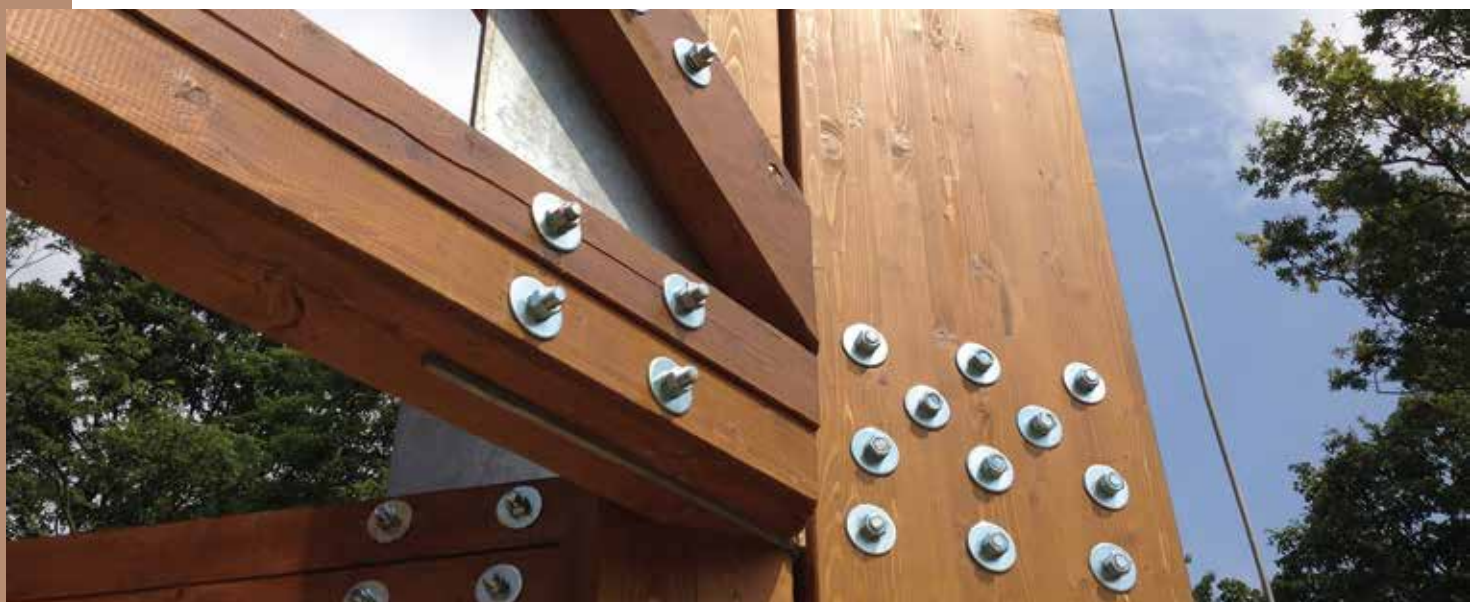
Kövestető kilátó rétegragasztott gerendái. Forrás: Szabó Péter
