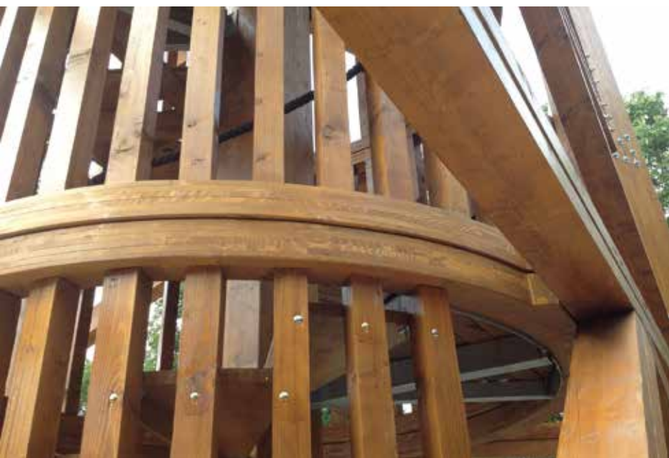
Kövestető kilátó tömbösített faelemei. Forrás: Szabó Péter
