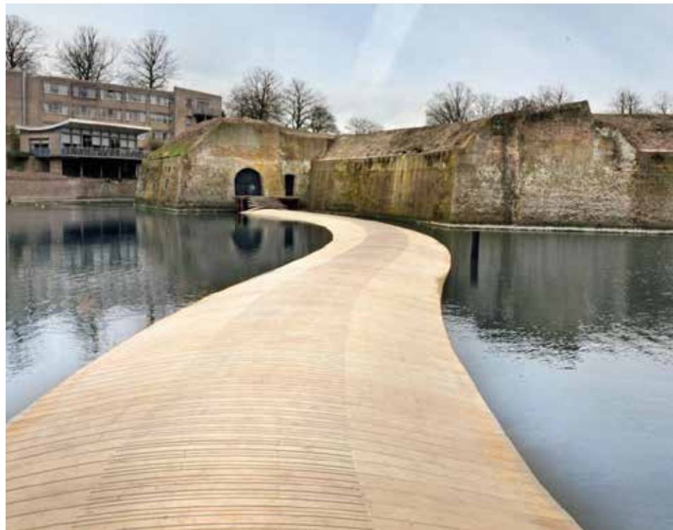
Acetilezett faanyagból készült „Lebegő híd” Hollandiában (forrás: Accoya)
