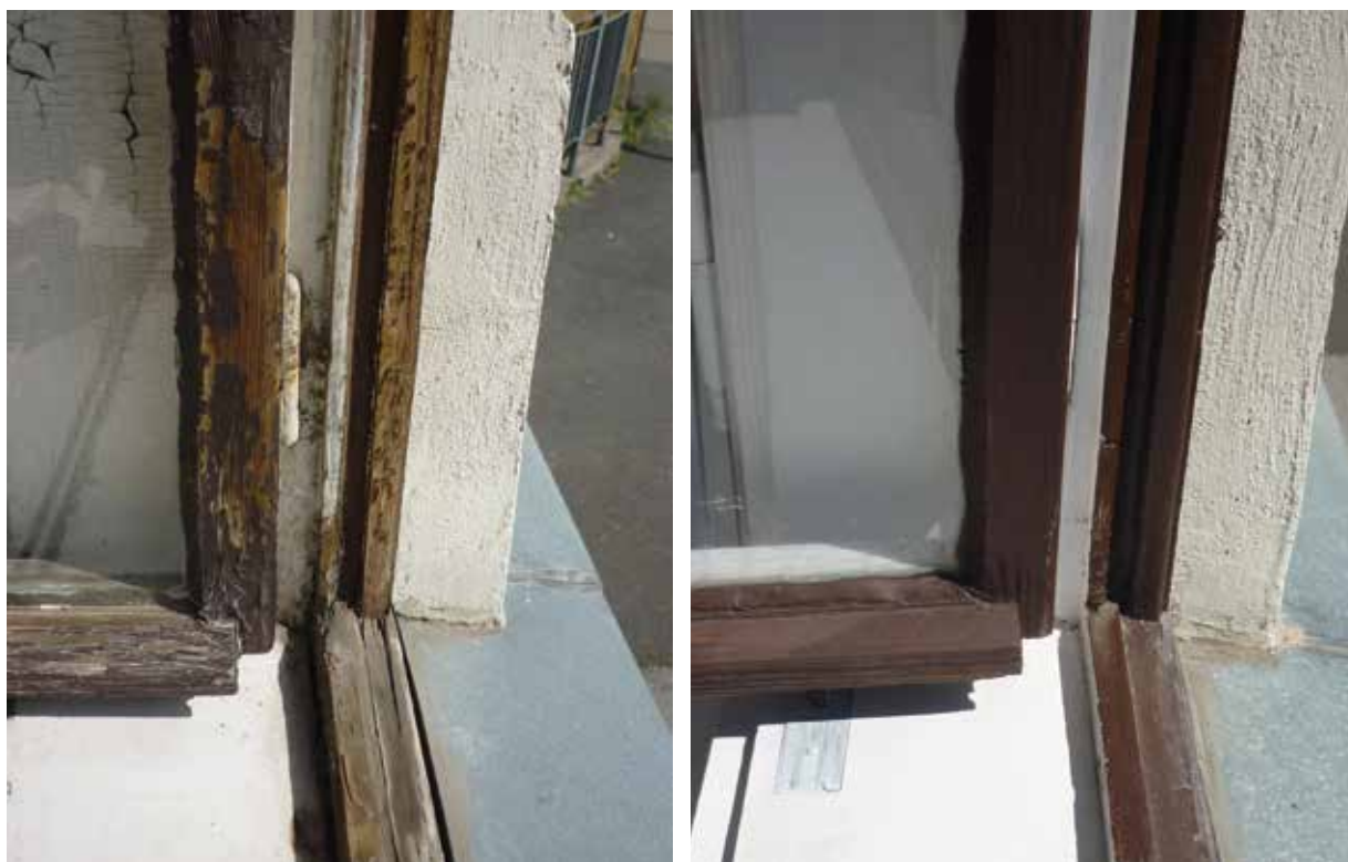
Az „S”-falcos megoldás kicsit bonyolultabbá teszi a munkát. Ilyen volt – ilyen lett
