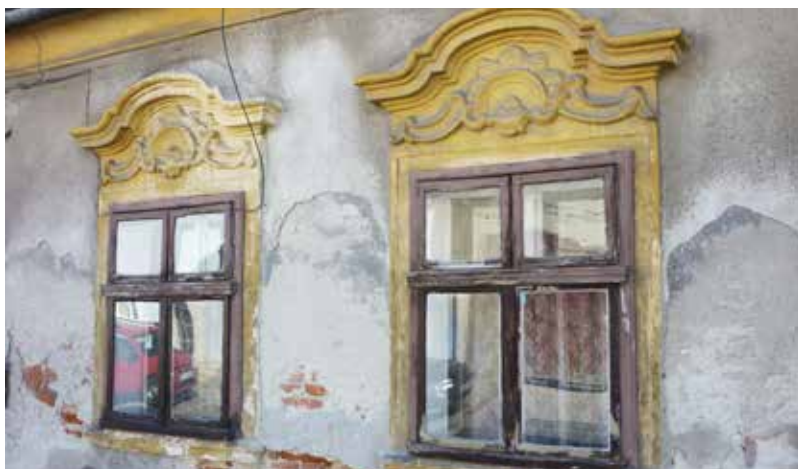
Különleges ablak kívülről záródó, de befelé nyíló alsó szárnyakkal. Csak kézműves munkával volna megmenthető
