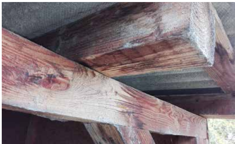
1. kép: A gombásodás folyamata kezeletlen fenyőgerenda esetén
