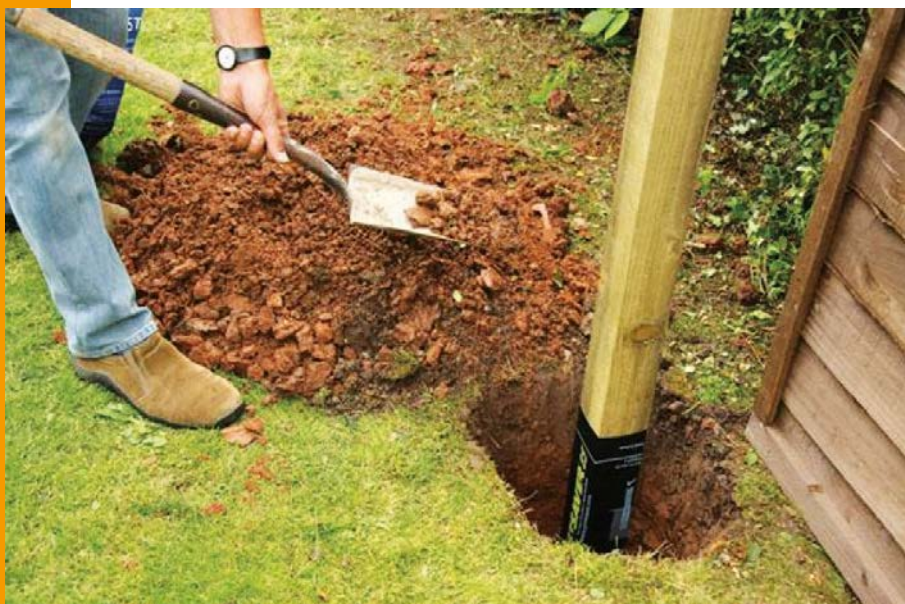
Postsaver fóliával védett oszlop telepítése
