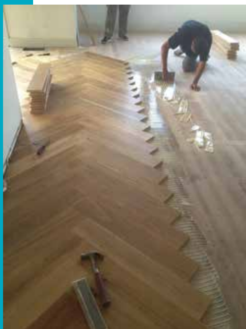
Ragasztót csak a következő művelethez szükséges mennyiségben hordjuk fel
