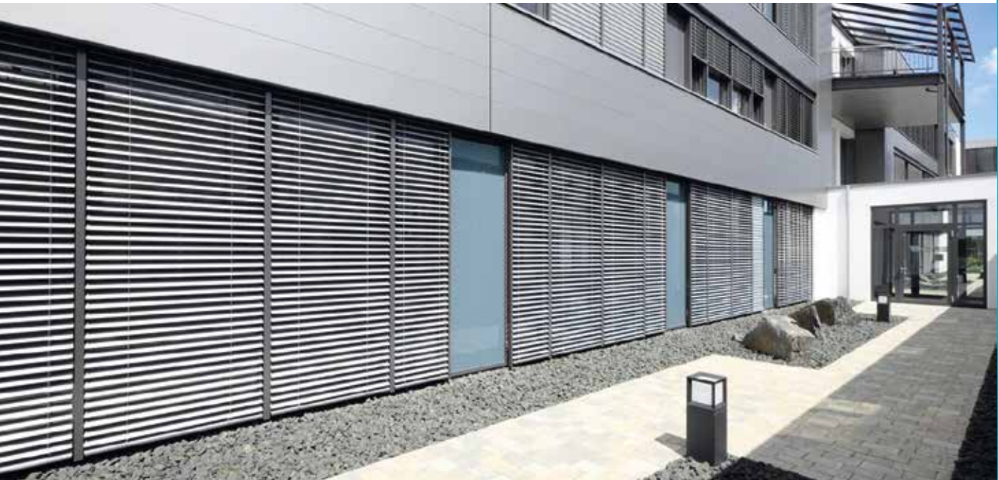
Prémium kategóriás, tolórendszerű alumíniumzsalugáterek – a felület kérésre fa hatású is lehet
