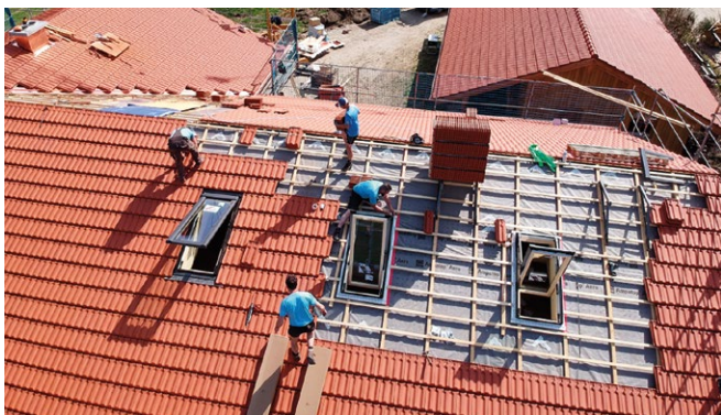
Beépítés alatt a Quadro R8 prémium kategóriás tetőablakok
