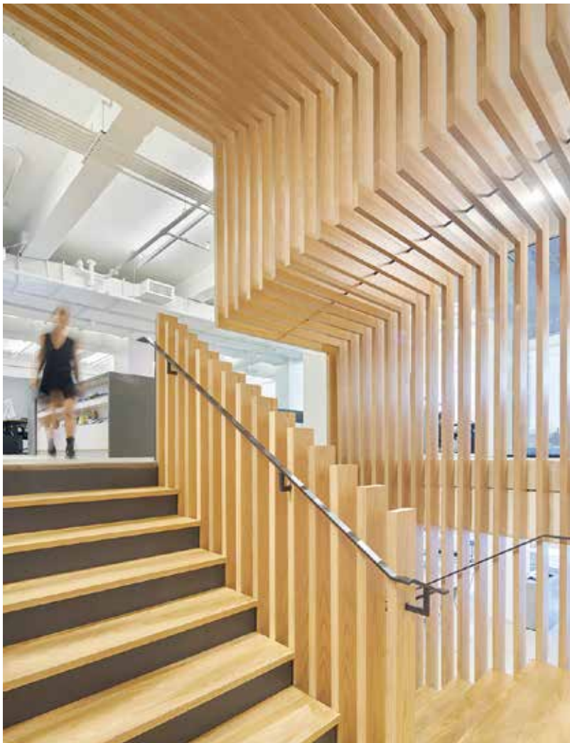
Közbenő fogódzó szükséges, ha a a lépcsőkar szélessége 2 m-nél nagyobb
