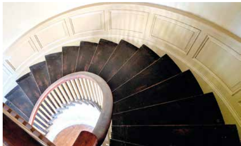
Elegendő belépőszélesség kell a húzott lépcsőlapokon való biztonságos közlekedéshez
