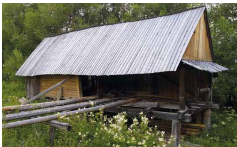
Évekkel a felújítás után is impozáns látvány – 2012
