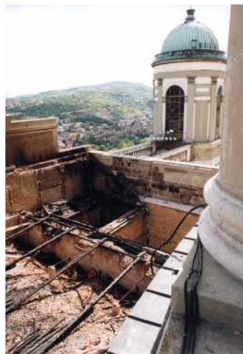
Az eldeformálódott rézlemezfedés maradványai utalnak a tűz hevére, Esztergom, 1993. (Schlosser Attila építész felvétele)
