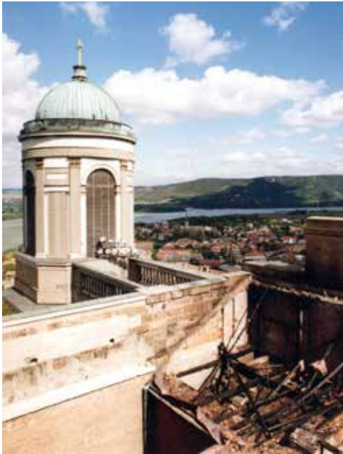
Az Esztergomi Bazilika tetőszerkezetének bontási munkái, 1993. (Schlosser Attila építész felvétele)
