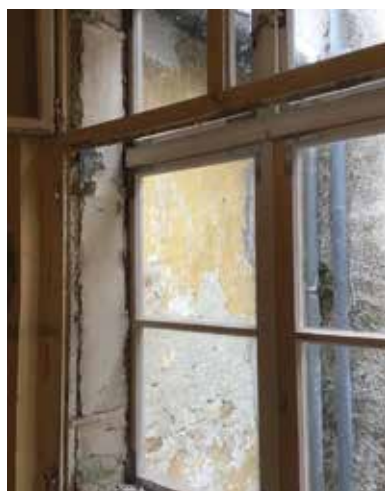
9. a kép: Kétrétegű gerébtokos ablak tokjait összekapcsoló pántok
