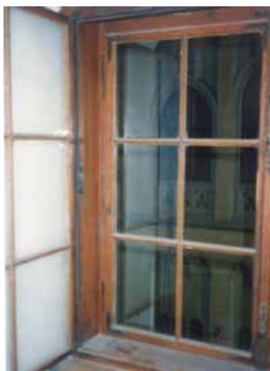
10. kép: Béléssel kötött, gerébtokos, be-be nyíló ablak (1860)
