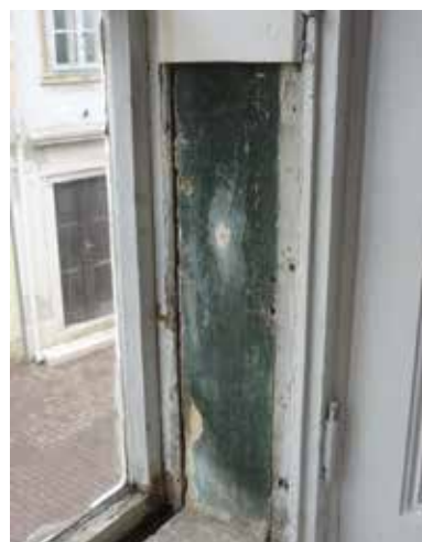
9. b kép: Kapcsolt gerébtokos, ki-be nyíló ablak bontásakor látszik a korábbi festett „falbélés” és rajta a későbbi deszkabélés
