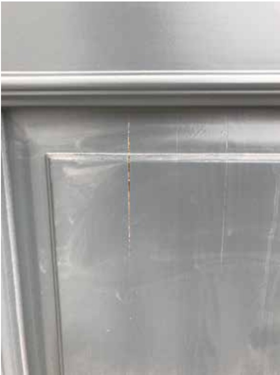
Költséges a javítás a beépítés után elrepedt tömör borovifenyő betét esetén (A szerző saját felvétele.)
