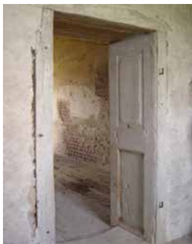
8. kép: Kettős borított ácstok
