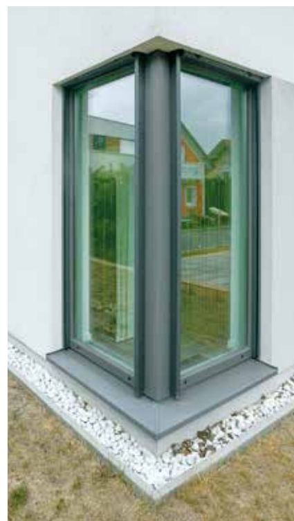
Háromrétegű üvegezésű hőszigetelt sarokablak egy passzívháznál
