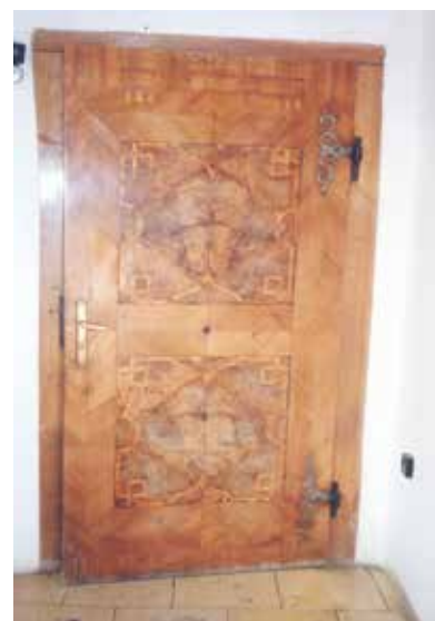
13. kép: Rakottas keresztajtó kereszt-pánttal, közepén a húzógomb nyomával és utólag bevéssett zárral
