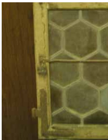
6. kép: Ólomüveges ablakszárny, az üveget tartó vaspálcákkal
