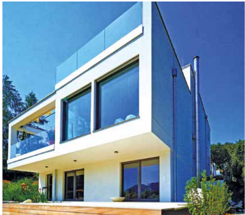
Többszintes passzív ház, emeletén fix üvegezésű ablakozással, míg az alsó nappali funkció miatt az erkélyajtók toló-nyíló működtetéssel biztosítják a lakás-kert kapcsolatot
