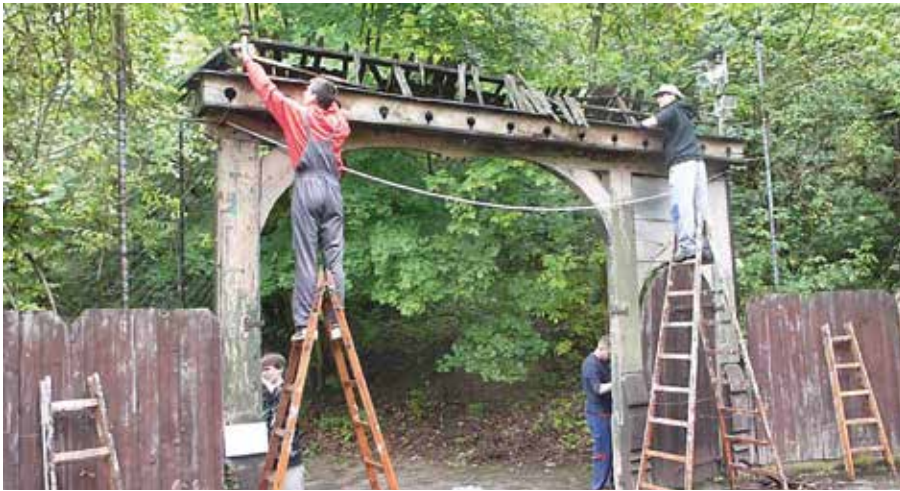
A felújítás kezdete a nagyon rossz állapotú székely kapun
