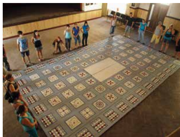
A végleges helyén a padlón összeállított kazettás mennyezet a festőcsapattal
