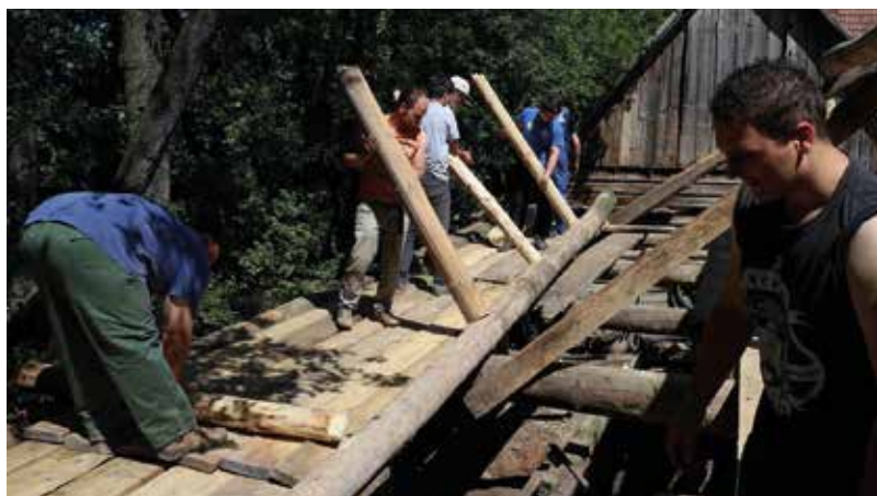
Az összeállított falelem felállítás előtt
