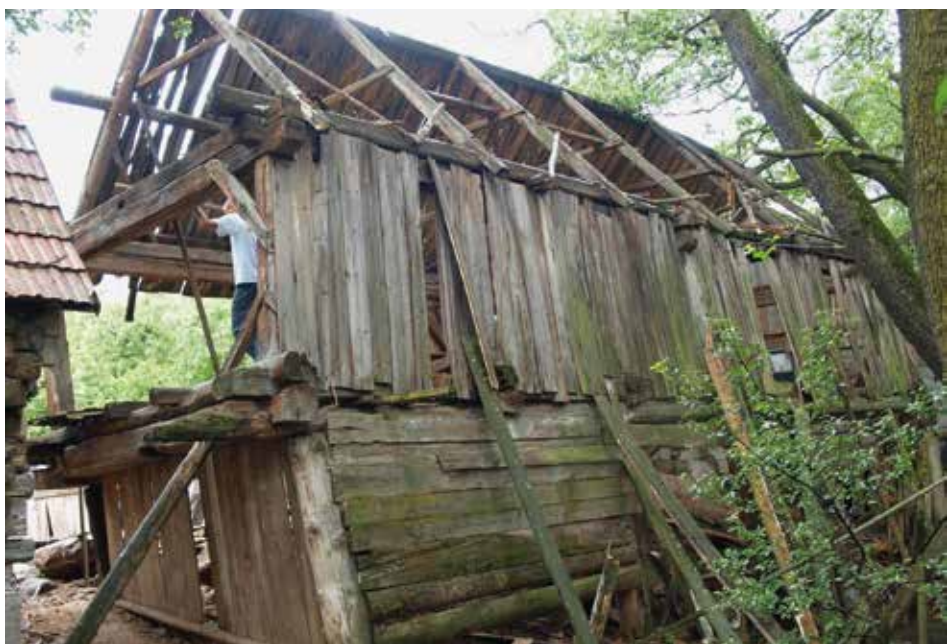
Bontás közben a tönkrement fűrész
