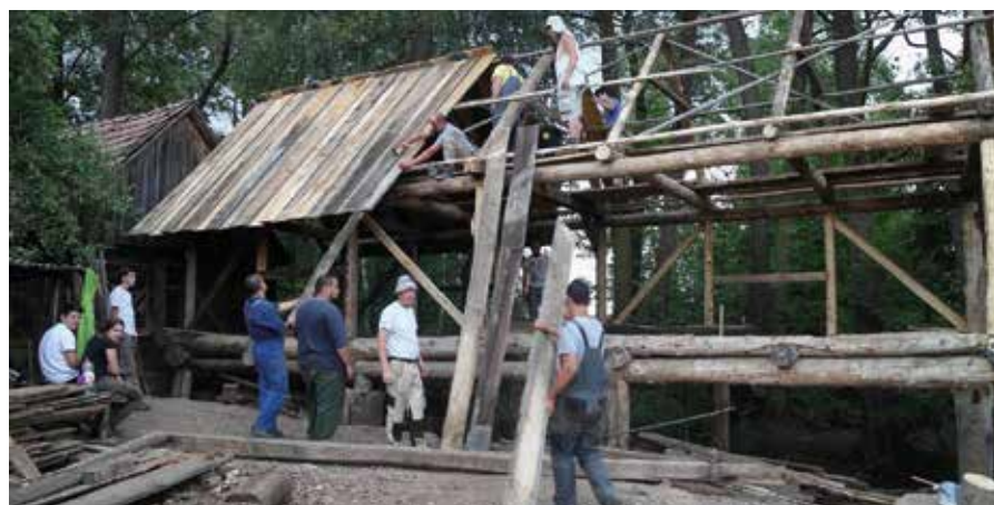
Elkezdődött a tető héjalása
