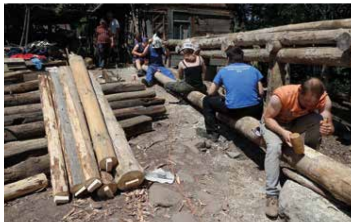
A tartóoszlopok és a szelemen csapozása összeépítéshez
