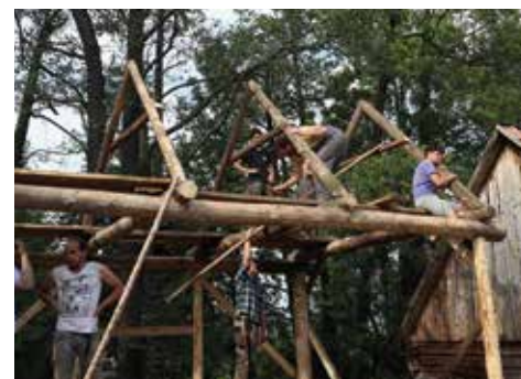
A szaruállások határozzák meg a tető formáját
