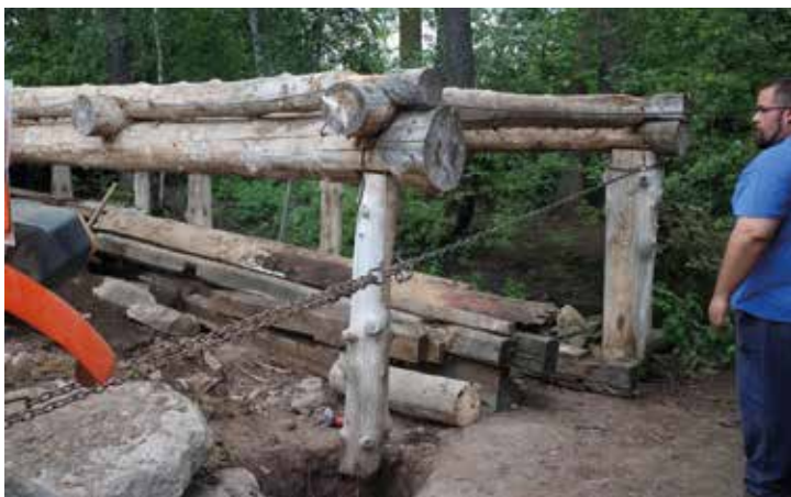
2018 – A beszűrűlt, elcsúszott gerendák visszahúzatása
