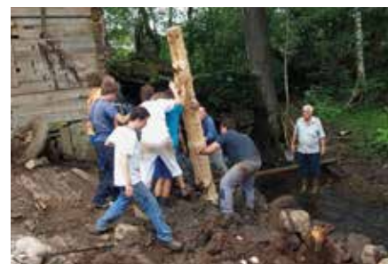
Az első új cölöp behelyezése
