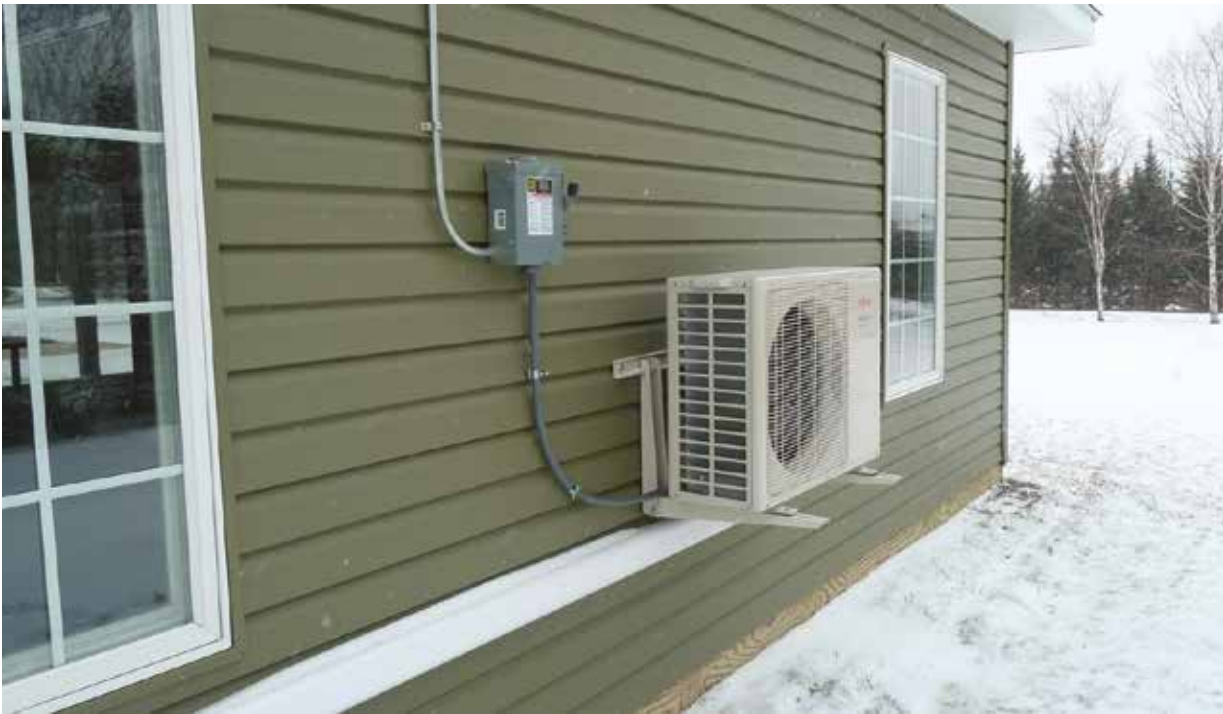
Alacsonyan elhelyezett kültéri egységnél a hómagasságot is vegyük figyelembe
