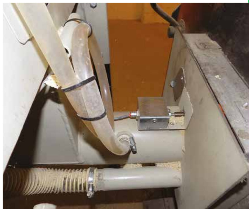
Ha a tüzelőanyag felgyülemlik, akkor a tűztérbe benyúló kapcsolószerkezet leállítja az adagolást. Ha ennek ellenére visszaégés történne, akkor a záró fólia elolvad és megszünteti az égést a kifolyó oltóvíz – ez áramszünet esetén is működik.
