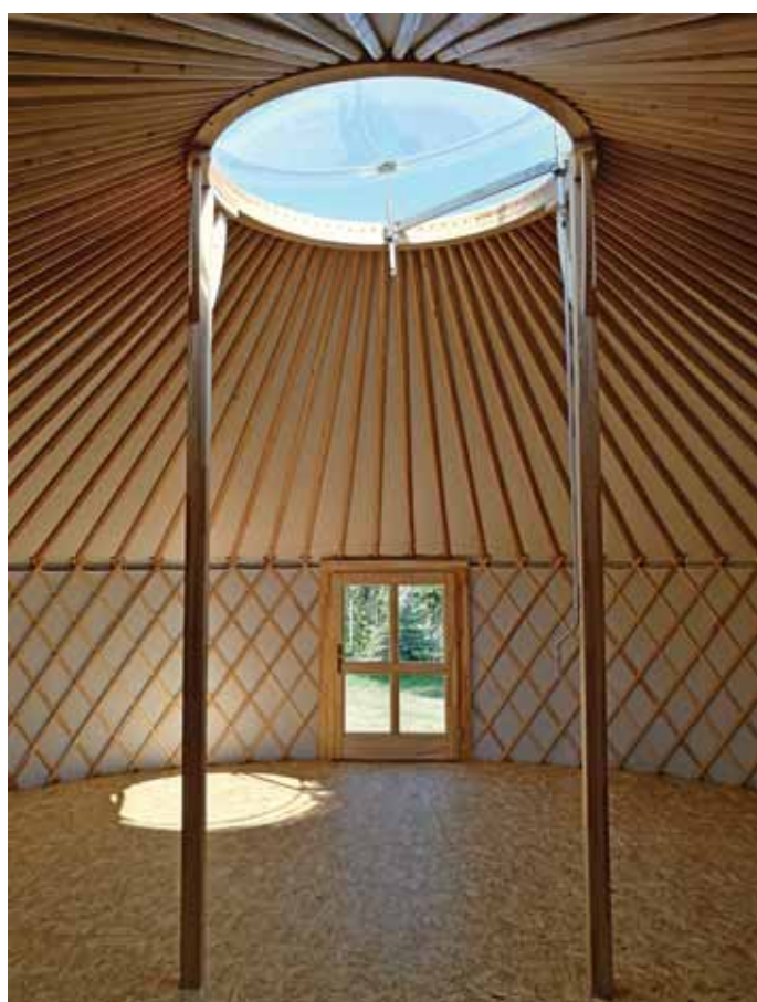
A felső világ: a tündök és a tetőrudak
