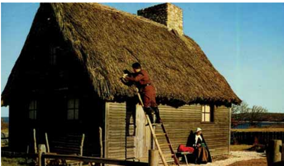
Múzeumi faház zsúptetejének javítása – Massachusetts
