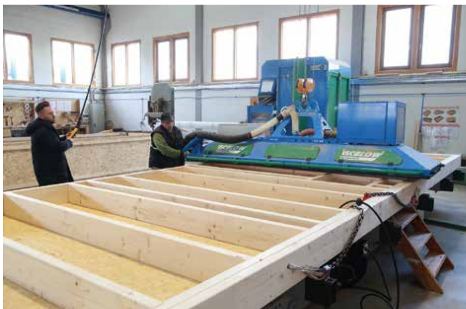
A farost alapú szigetelőanyag betöltése
