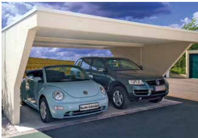
Favázrendszerű, kétállásos autóbeállónál a szerkezeteket takaró burkolattal látták el az épített környezetbe való alkalmazkodás miatt
