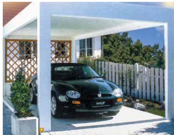
Stabil építésű, favázrendszerű járműbeálló a lakóház előkertjében, utcai kapcsolattal
