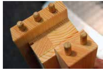
2. kép: illesztett kontraprofil köldökcsappal
