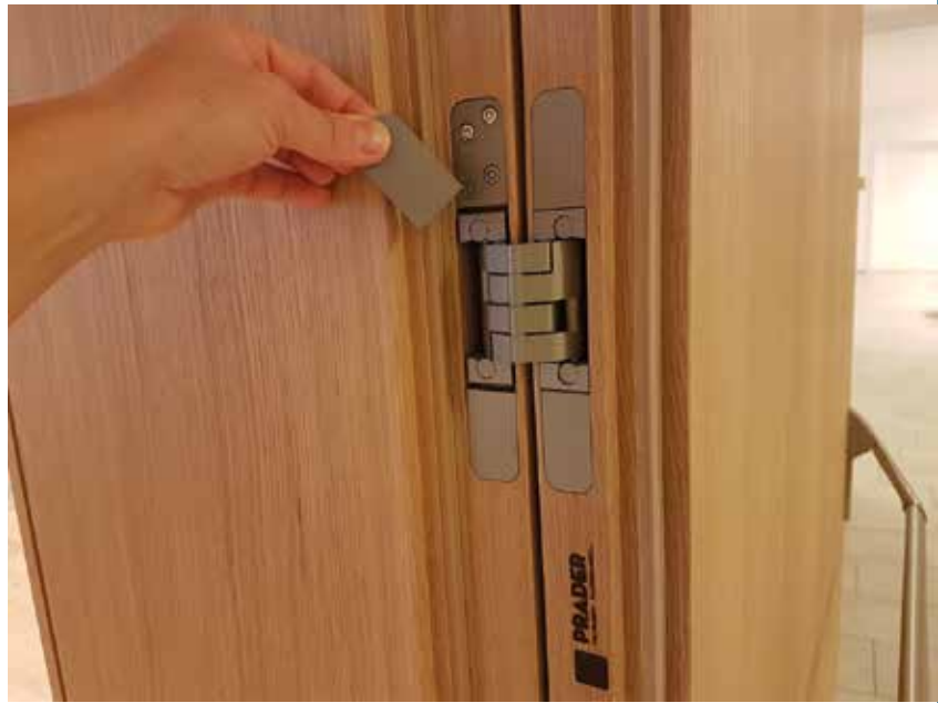
Rejtett 3D-s pánt esztétikus takarólemezzel – BaSys Pivota
