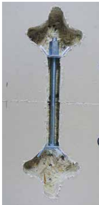
A kész fészkek a munkalap-összehúzó fogadására.
