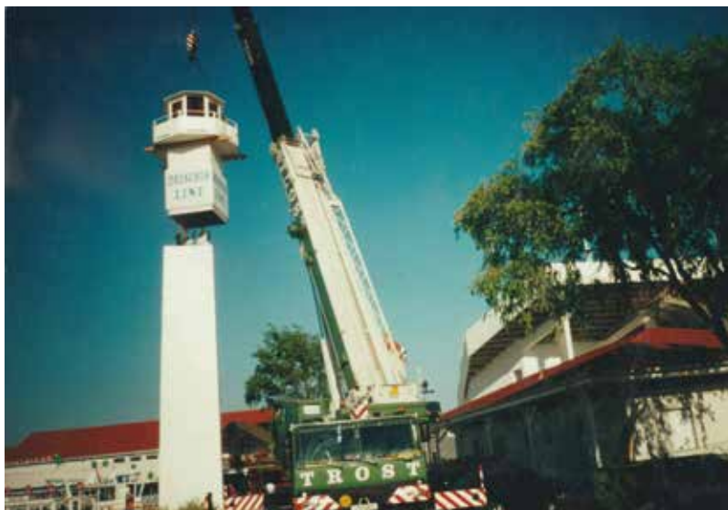
A világítótornyó összeállítás. A toronyban József felügyeli a munkát.
