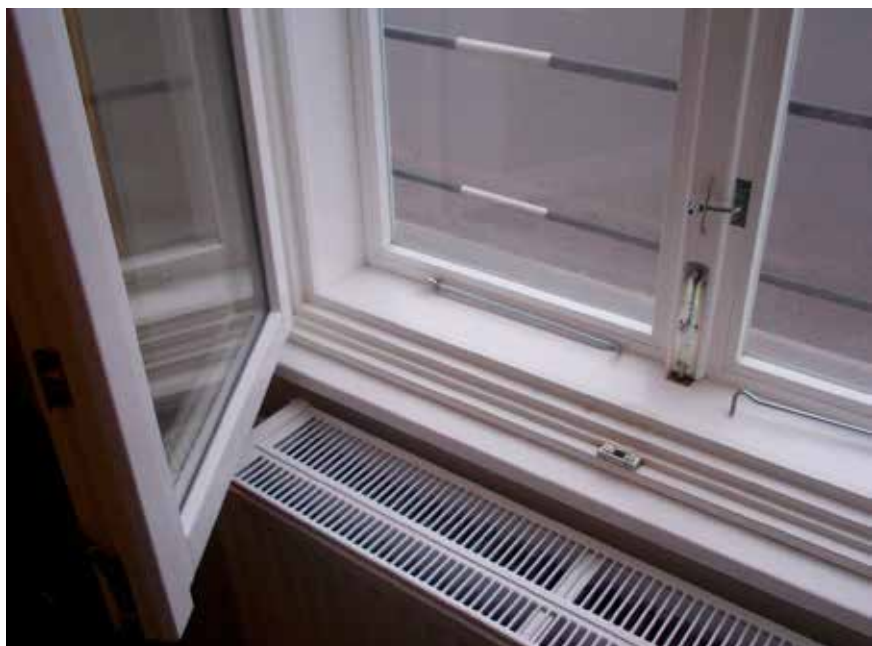
Régi külső, modern belső: kifelé nyíló 4 mm float üveggel ellátott szárnyak az eredeti alapján készítve, belül pedig egy bevált, korszerű 68 mm profilú rendszer, a megfelelően méretezett osztásokkal. (Foto: Póczafa Ajtó & Ablak)
