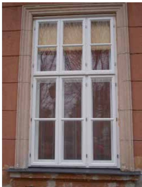
Régi külső, modern belső: kifelé nyíló 4 mm float üveggel ellátott szárnyak az eredeti alapján készítve, belül pedig egy bevált, korszerű 68 mm profilú rendszer, a megfelelően méretezett osztásokkal. (Foto: Póczafa Ajtó & Ablak)
