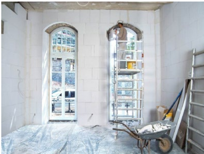
A Multipor ásványi hőszigetelő rendszerrel párazáró réteg beépítése nélkül is könnyen kialakítható belső oldali hőszigetelés. Emellett a Multipor nem csak belső oldalon használható, az épület külső homlokzati hőszigetelésére is alkalmas. (static.regon.hu)
