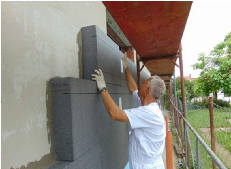
A grafitos hőszigetelő lapok a hagyományos EPS lapokhoz képest 23 százalékkal jobb hőszigetelő-képességgel rendelkeznek, így vékonyabb kivitelezést engednek meg, azaz némi helyet is meg lehet velük takarítani. (bachl.hu)
