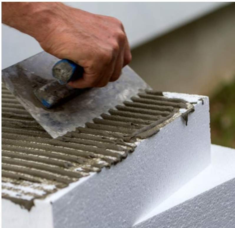
A hungarocell, azaz EPS anyaga az úgynevezett sztirolgyöngy. Mivel 2-4 térfogat százaléknyi vizet is képes felvenni, olyan helyre tegye a lapokat, ahol nem éri nedvesség, vagy páralecsapódás. Mivel érzékeny az ultravioleta sugárzásra, nem szabad napfénynek érnie. (hungarocell.hu)
