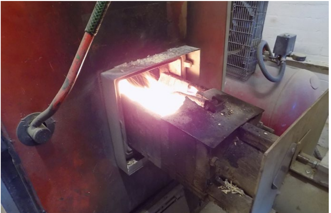
Rakéták begyűjtve: egy Halex3 apríték égőfej üzem közben. (a szerző saját felvétele)
