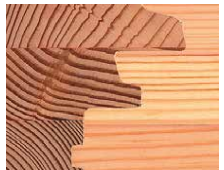
► 2. kép: ablaktok, csapos és kontraprofilos kötése
