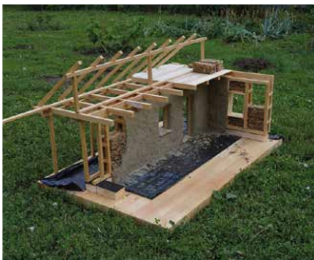
► A makett jól mutatja a hagyományos ácsszerkezet közé rakott szalmabálás építést. 9
