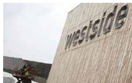
► Westside szabadidő komplexum falburkolata hosszitoldott akác elemekből
