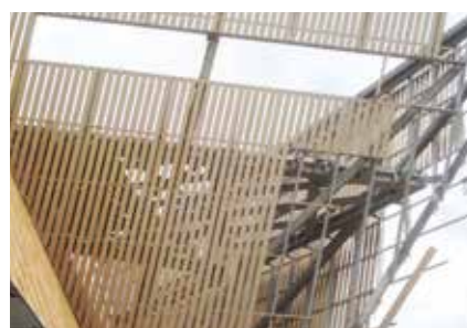
▶ Monsi Kongresszusi Központ építése hosszitoldott akác elemekből
